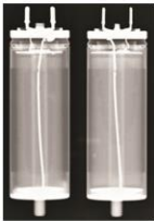
فیوز داخلی فشاری در خازن های تک فاز
